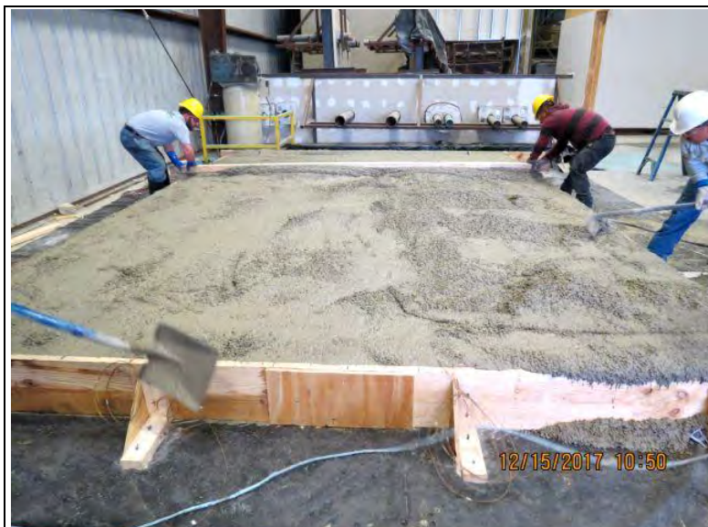
Photo No. 20 Concrete pour
