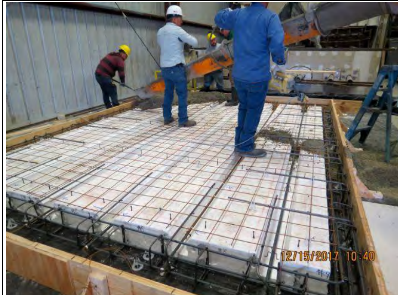
Photo No. 19 Concrete pour
